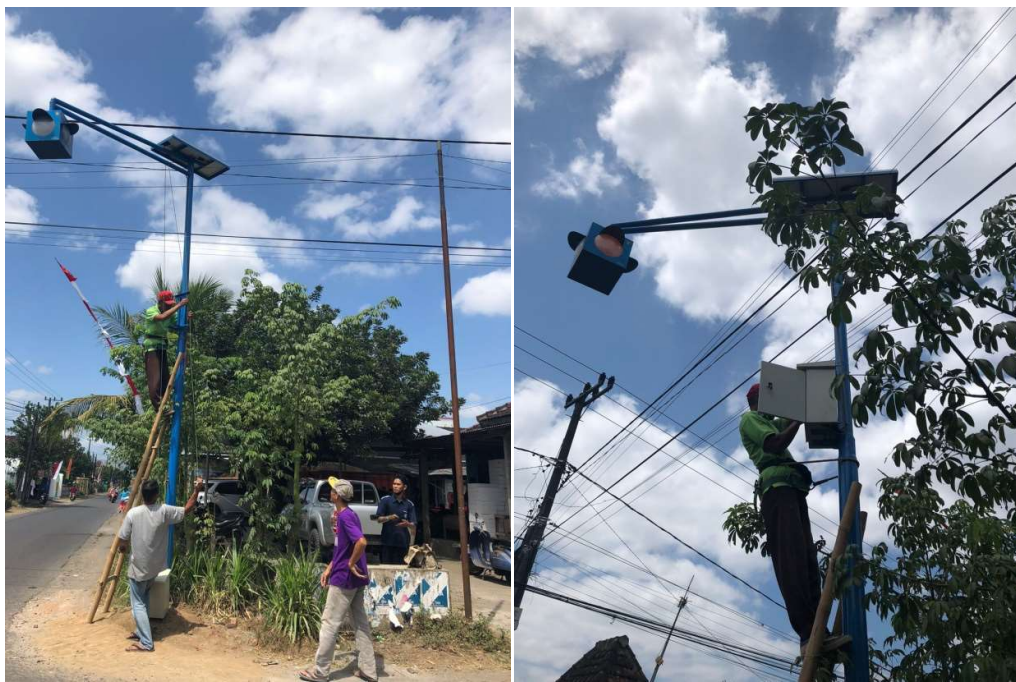
Gambar 8. Pemasangan Lampu Peringatan Bertenaga Surya
