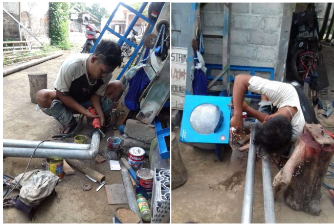
Gambar 7. Proses perakitan Lampu Peringatan Bertenaga Surya
